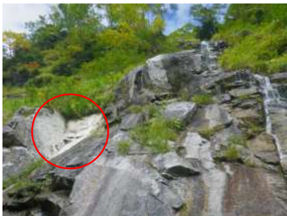
【崩落したバンド跡】
